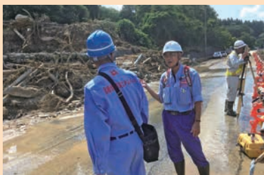
R113 被災箇所の現地確認
