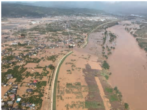
撮影：2019年10月13日 場所：長野市穂保 千曲川堤防決壊地点周辺 提供：長野県建設部（災害デジタルアーカイブより）
