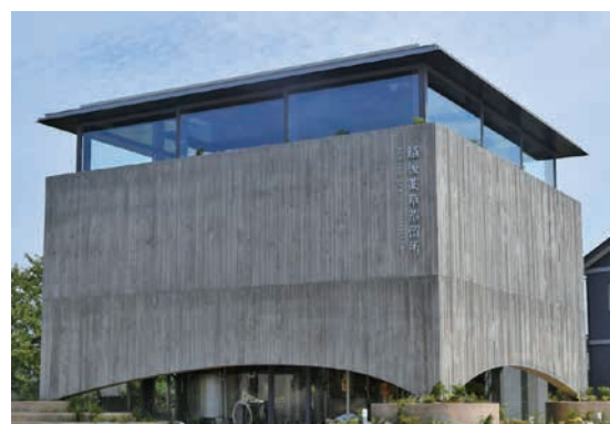
蒸留所は取材時にはまだ設備工事中。植栽は原料に使っている野草を中心にしたが「ヨモギは恐ろしく増えるので植えられませんでした」とのこと
