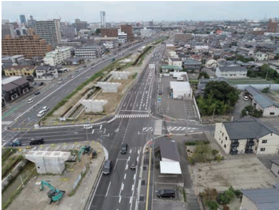
セパレート化直後の栗ノ木バイパス（令和4年10月）
