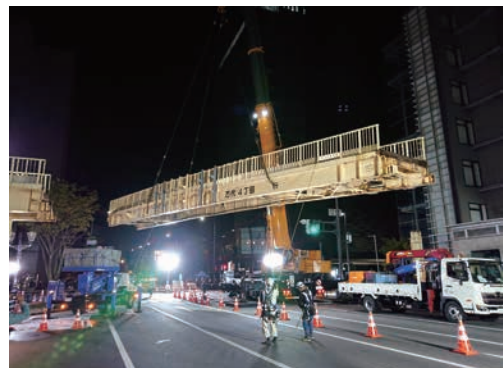
東港線十字路の横断歩道橋撤去(令和4年9月29日未明)
