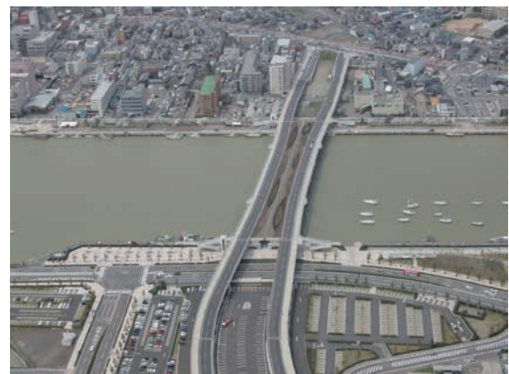
高架橋の接続を待つ柳都大橋
