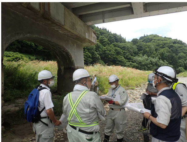
写真 姫川橋現地調査
