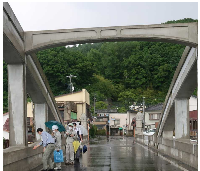
佐久穂町の栄橋（鉄筋コンクリートローゼ橋）
