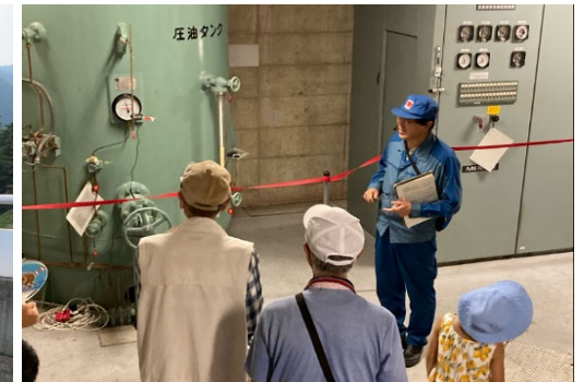
大町発電所内部見学
