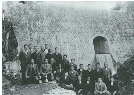
日影第一号砂防堰堤（昭和27年竣工）戦後の代表施設。当時日本有数の規模を誇る。後に国の登録有形文化財に登録
