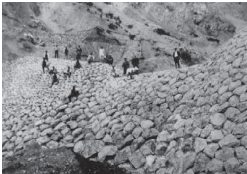
直轄初期に着工した六郎谷第1号砂防堰堤（大正10年頃撮影）。後に国の登録有形文化財に登録【写真出典】神岡町史写真編
