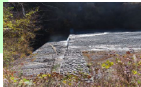
唐沢砂防堰堤
