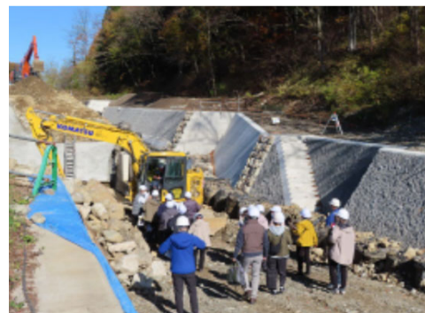
武智川下流床固工群
