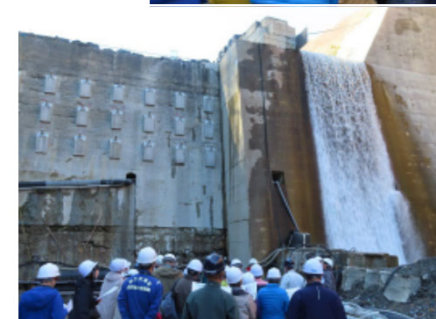
空谷砂防堰堤
