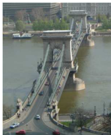
写真7 170年経過した鎖式吊橋
