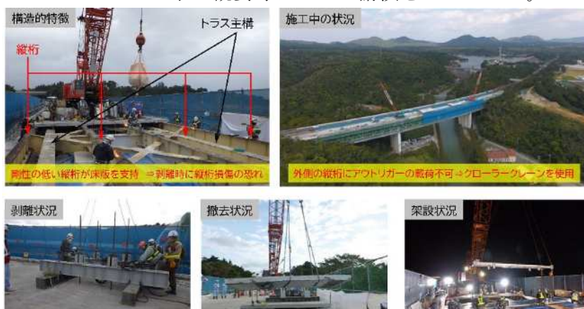
写真9 四国支社管内のトラス橋の床版打替え事例
