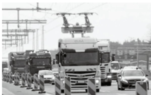
写真2 パンタグラフを使った車両走行
