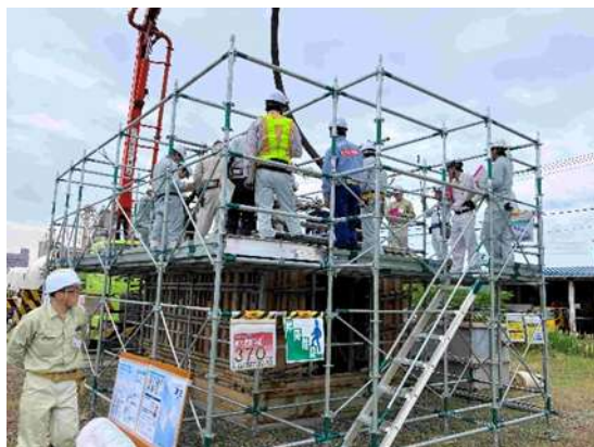
写真2：打設実習の状況
