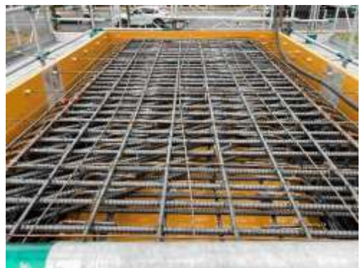
写真1：頂版部配筋状況
